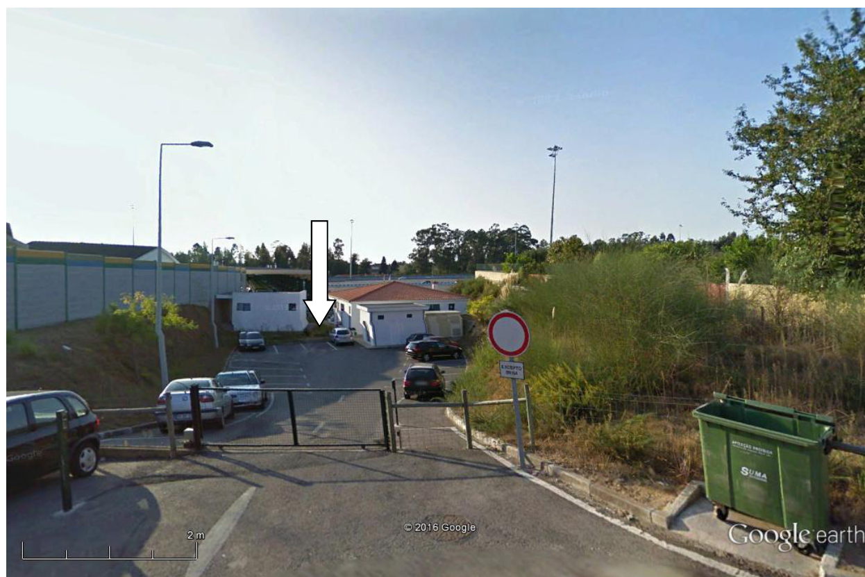
Figura 2 – Perspetiva do local onde foi colocada a estação móvel de qualidade do ar durante as medições realizadas no local de medição P2 – Km 285+000 (este) – Sublanço IC24 / Carvalhos (adaptado de Google Earth).
